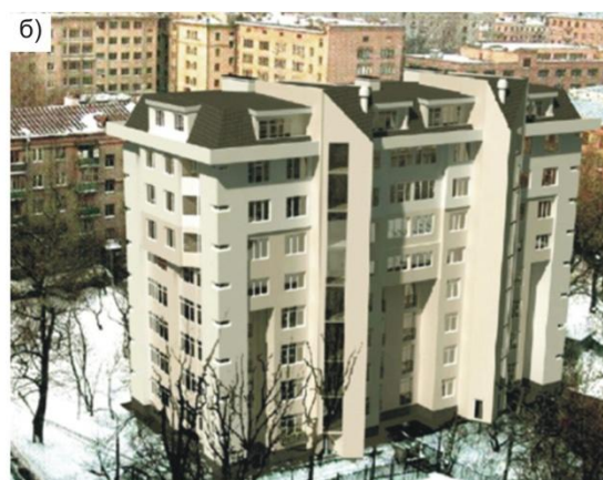
Рисунок 3 - Реконструкция зданий с надстройкой этажей: а) реконструкция 5-этажного жилого дома серии 1-515 с пристройкой пролетов и надстройкой 4-х этажей (дом вторичной застройки – ДВЗ), Химкинский бульвар 4; б) реконструкция 4-хэтажного кирпичного жилого дома с надстройкой пяти этажей, пристройкой лифтовых шахт, эркеров
