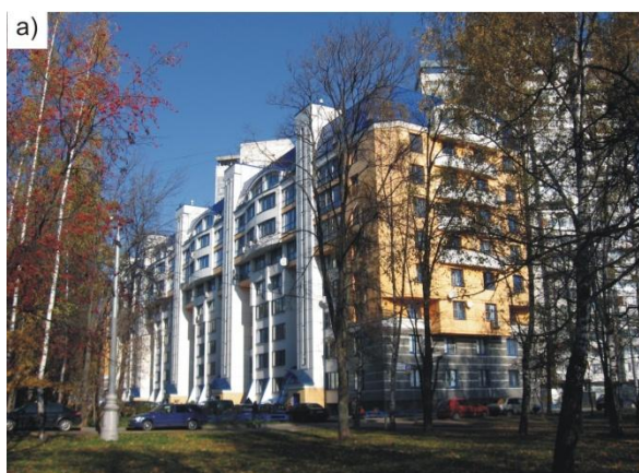
Рисунок 3 - Реконструкция зданий с надстройкой этажей: а) реконструкция 5-этажного жилого дома серии 1-515 с пристройкой пролетов и надстройкой 4-х этажей (дом вторичной застройки – ДВЗ), Химкинский бульвар 4; б) реконструкция 4-хэтажного кирпичного жилого дома с надстройкой пяти этажей, пристройкой лифтовых шахт, эркеров
