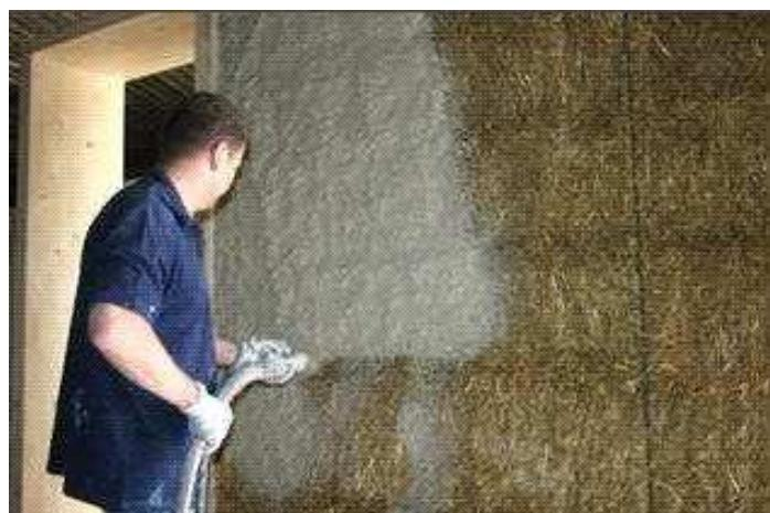
*Рисунок 8 – Механизированное нанесение глиняной штукатурки*
