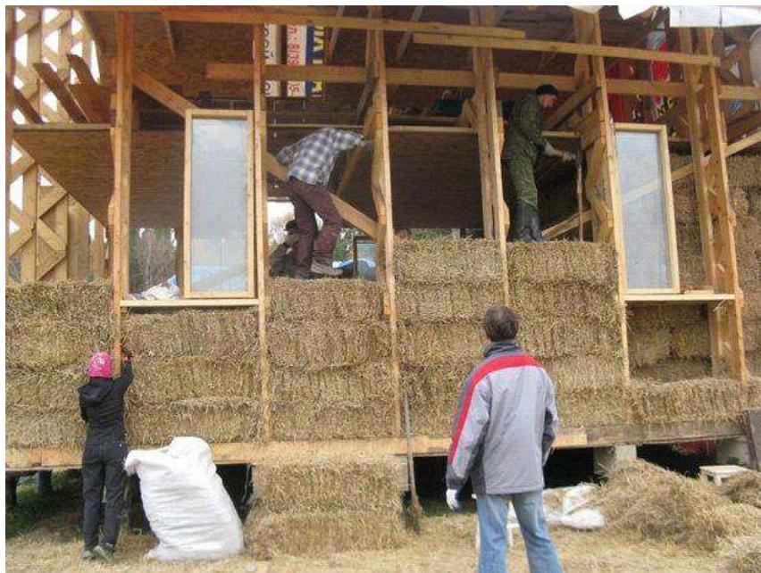
*Рисунок 3 – Устройство стен соломенного дома*
