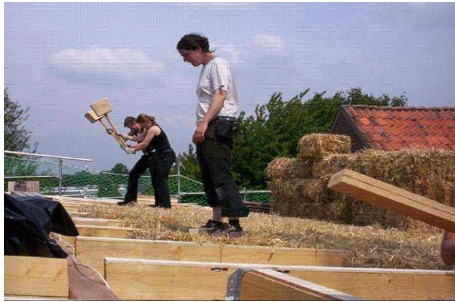
Рисунок 5- Устройство крыши в соломенном доме
