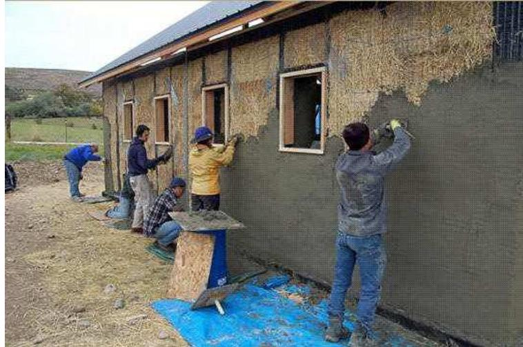
*Рисунок 7 – Нанесение модифицированной штукатурки на основе глины на поверхность соломенной стены*
