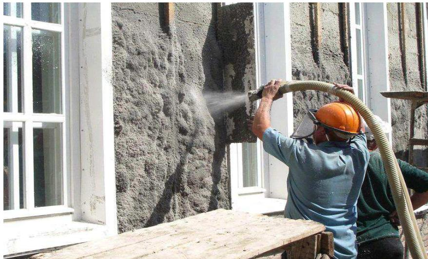
***Рисунок 9 – Нанесение теплоизоляционного материала «Тепломак» механизированным способом***
